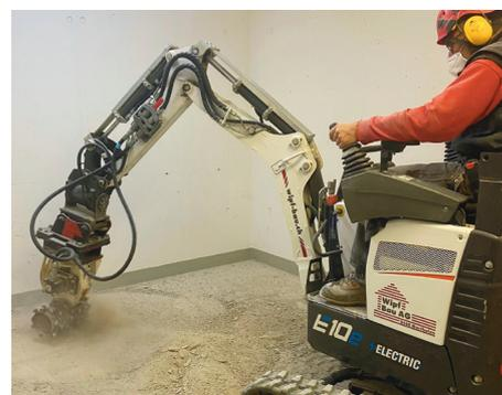
störungsfrei im Einsatz. «Die Maschine leistet erstklassige Arbeit und durch den Wegfall von Verbrennungsabgasen im Arbeitsbereich ist keine zusätzliche Belüftung notwendig», erklärt der Unternehmer und ergänzt: «Zudem sind die Geräuschemissionen deutlich niedriger als beim vergleichbaren Verbrenner, was eine bessere Verständigung auf der Baustelle erlaubt, das trägt massgeblich zur Sicherheit bei. Wir können die Maschine nur empfehlen.»
